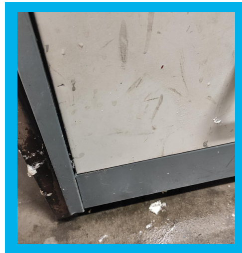
Dépot de mousse / Schuimafzetting / Schaumeinlage
